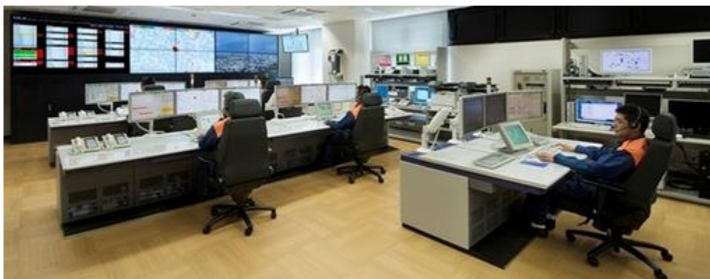
■高機能消防指令センター
