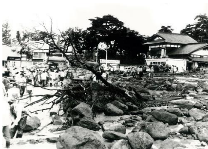
■昭和 50 年蔵助沢土石流災害(弘前市)
