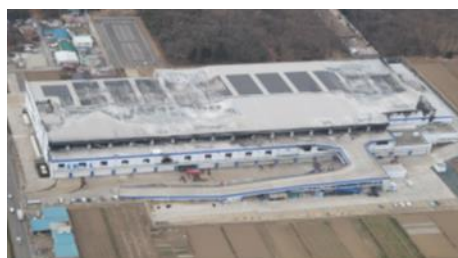
出典]埼玉県三芳町倉庫火災を踏まえた防火対策及び消防活動のあり方に関する検討会
