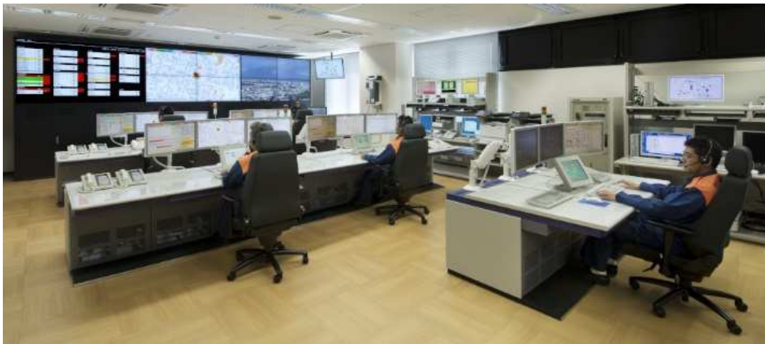
写真 弘前地区消防事務組合 消防指令センター 令和4年4月1日現在
