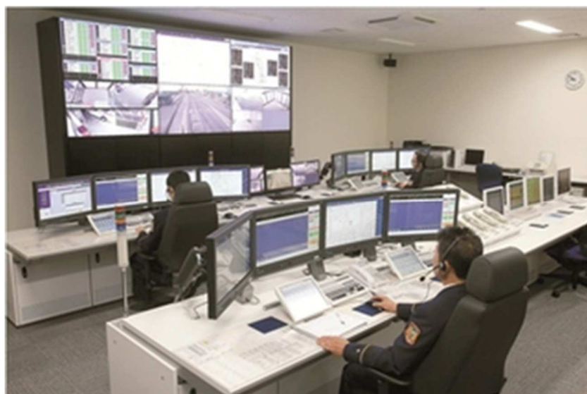
写真 五所川原地区消防事務組合 消防指令センター 令和4年4月1日現在
