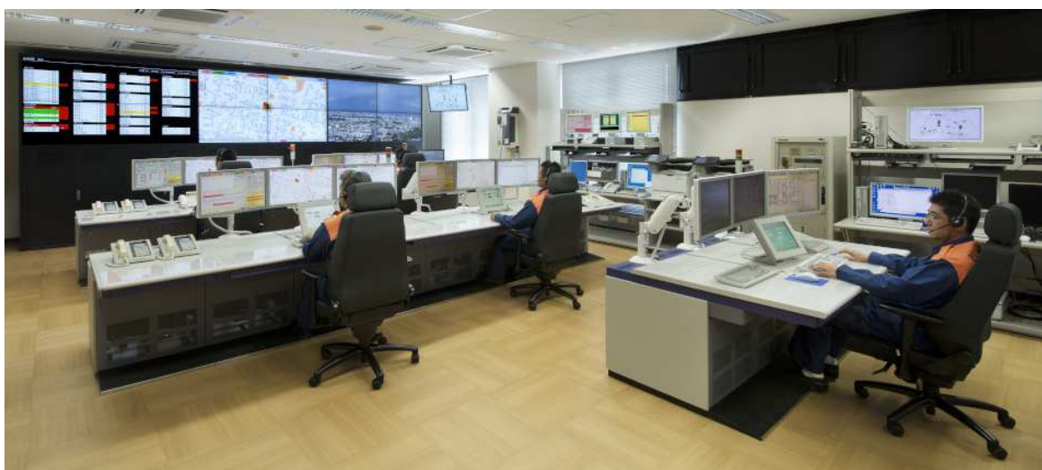
弘前地区消防事務組合 消防指令センター 令和3年4月1日現在
