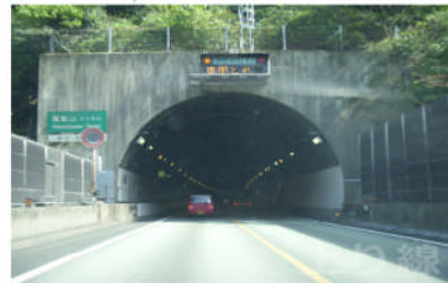
東北自動車道 坂梨トンネル (基地2)
