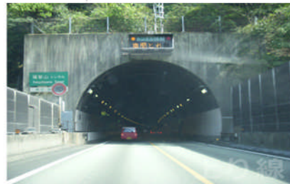
東北自動車道 坂梨トンネル (基地2)
